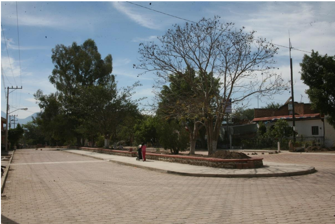
Construcción de camellón y adoquinamiento en la entrada principal en la Delegación Chapulimita.
