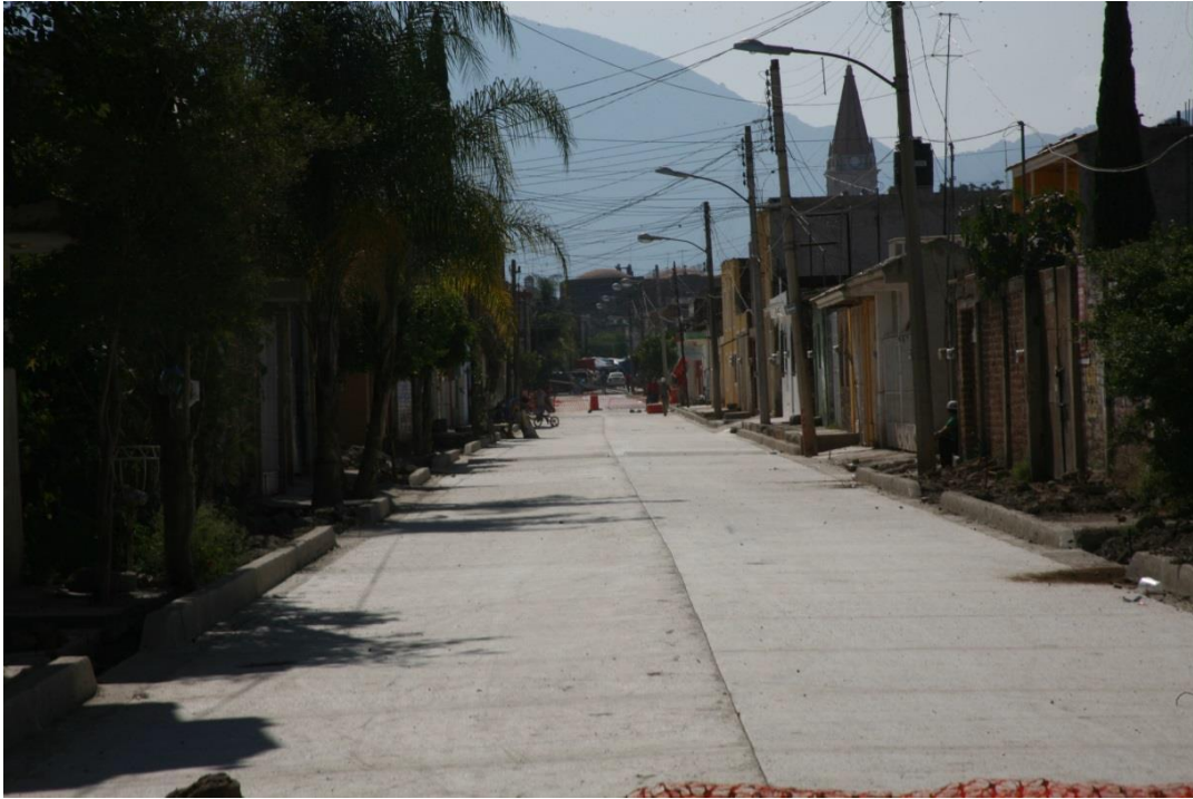
Calle Miguel Hidalgo (pavimentación con concreto hidráulico)
