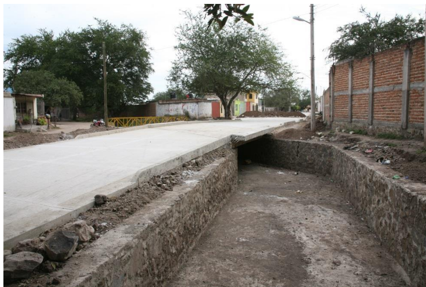
Construcción de Puente en arrollo Santa Anita, cruce con la calle 20 de Noviembre
