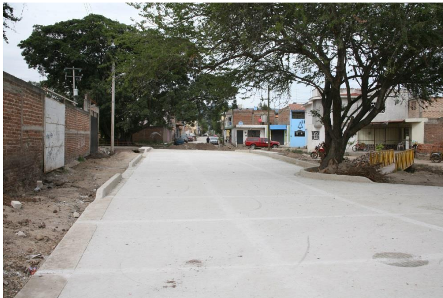
Calle 20 de noviembre (pavimentación con concreto hidráulico)
